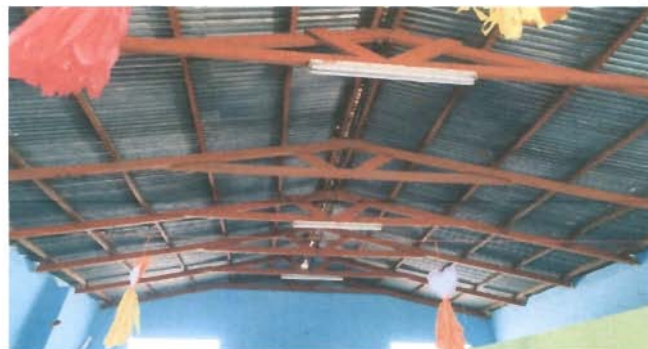
Foto 2: Sustitución techo de salón parte atrás
