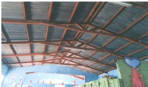
Foto1: Sustitución de estructura techo salón
