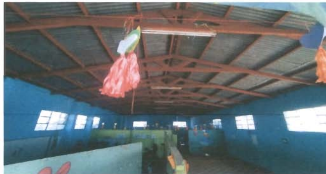
Foto 4: Sustitución techo de salón vista completa
